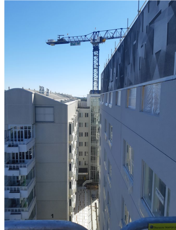
KYS Uusi Sydän projektin 1C2 –vaiheen uudisrakennus on harjakorkeudessa. Kuva Hanna Tossavainen, Rakennusliike Lapti.
